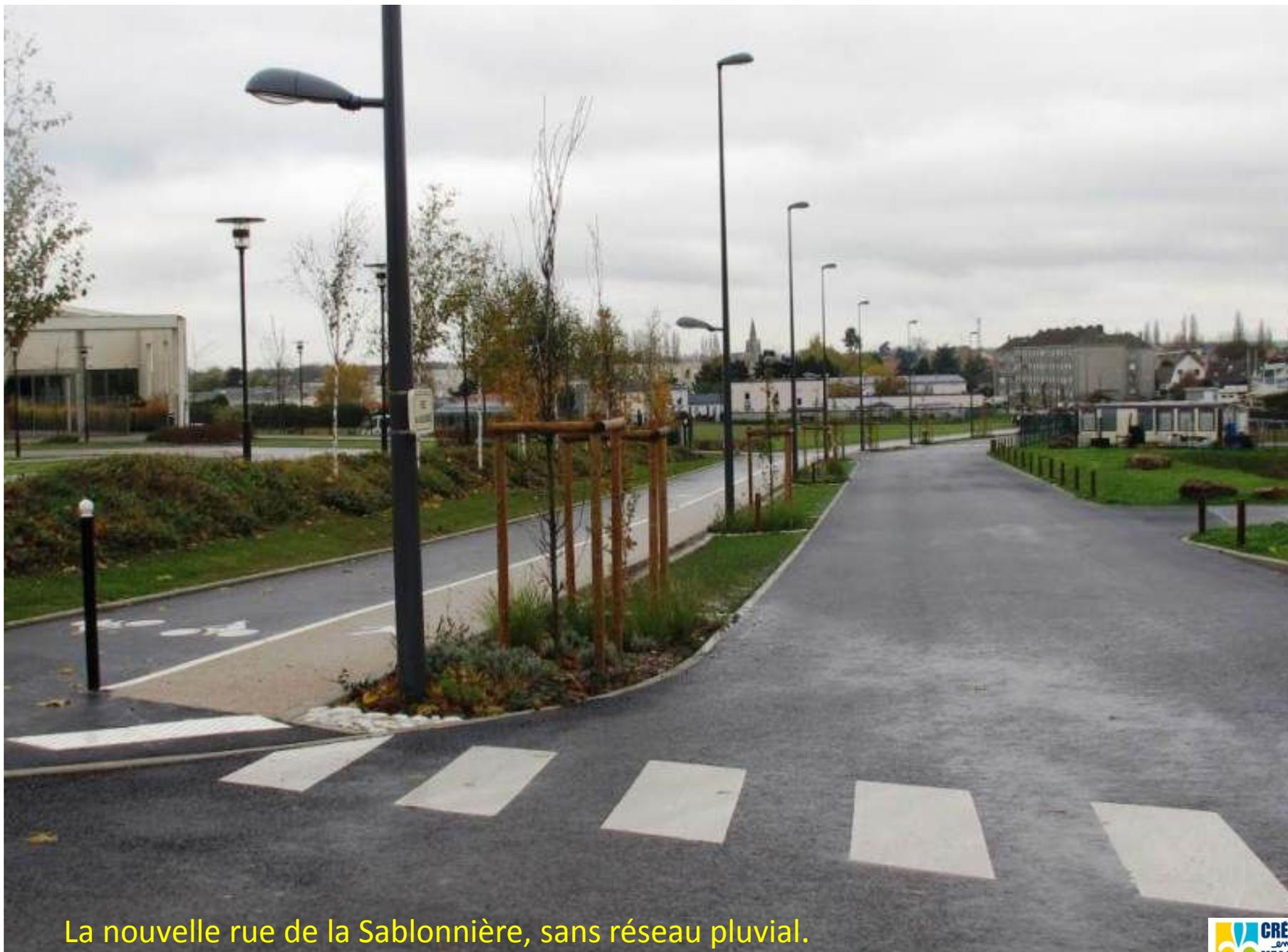
La nouvelle rue de la Sablonnière, sans réseau pluvial.
