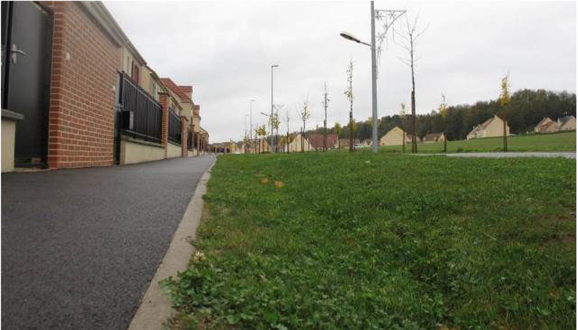
Les noues réduisent la vitesse d'écoulement et favorisent l'infiltration des eaux de surface. Grâce à des profils très doux, elles intègrent l'espace sans rupture nette et peuvent être gérées facilement en tonte ou en fauche.
