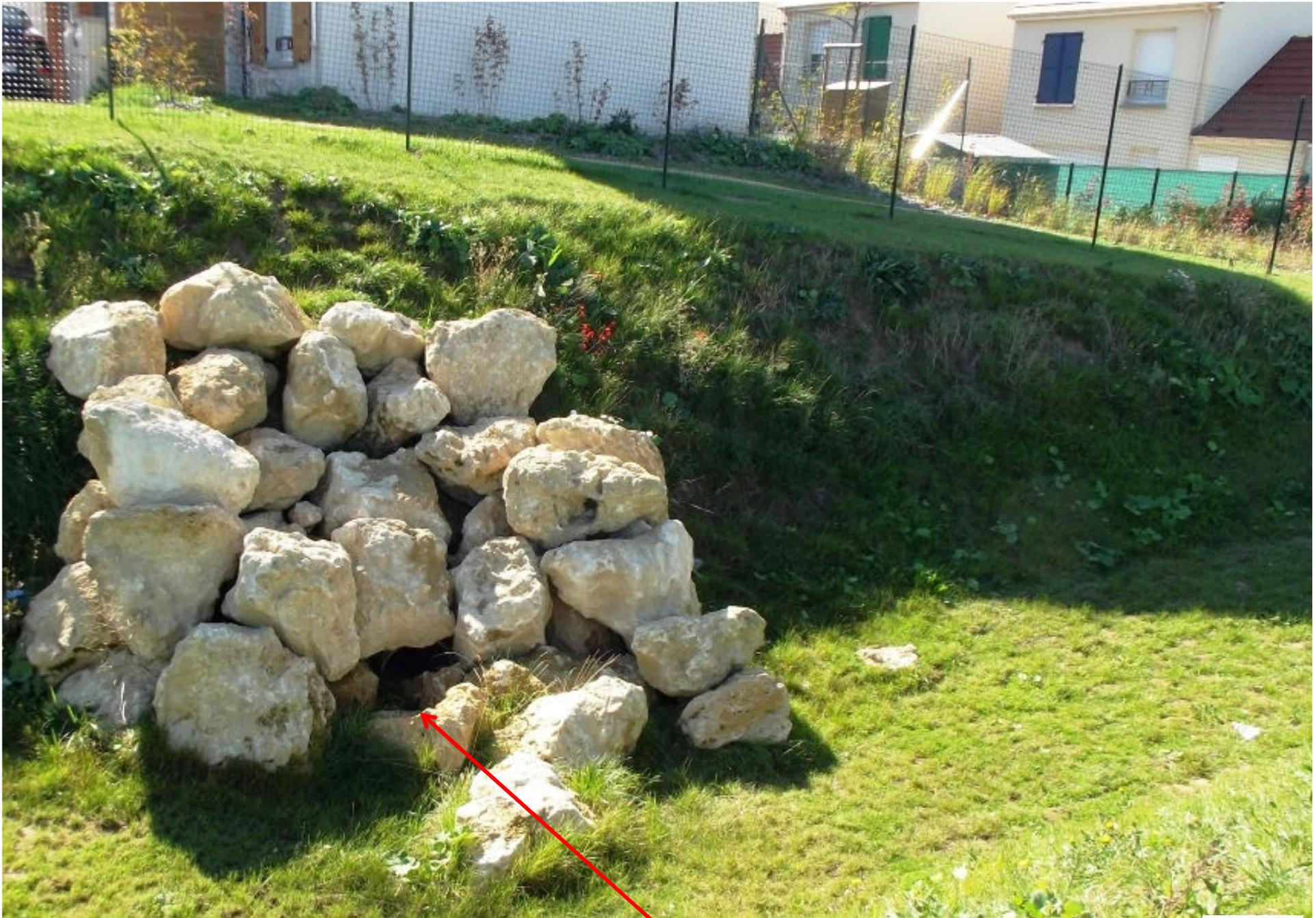
Buse d'évacuation des eaux pluviales dans le bassin d'infiltration
