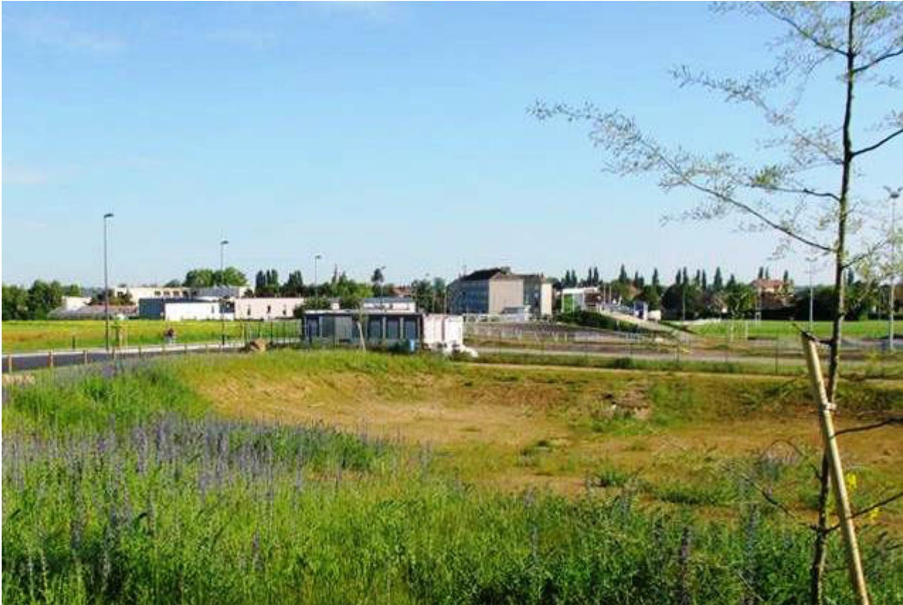
Le bassin d'infiltration a un rôle identique aux noues mais offrent des capacités de rétention et d'infiltration plus importantes.
