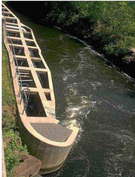
*Illustration des écoulements en aval d'une passe à bassin. La veine d'eau issue de l'entrée de la passe est visible sur plusieurs mètres en aval (aération) et vient ensuite se confondre tangentiellement avec l'écoulement principal.*
