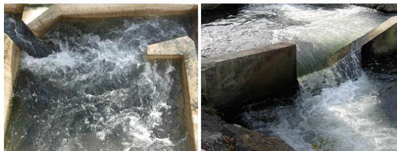
**Illustrations des conditions d'écoulement dans un bassin d'une passe à fente verticale et au niveau d'une chute d'eau d'une cloison de pré-barrage.**
