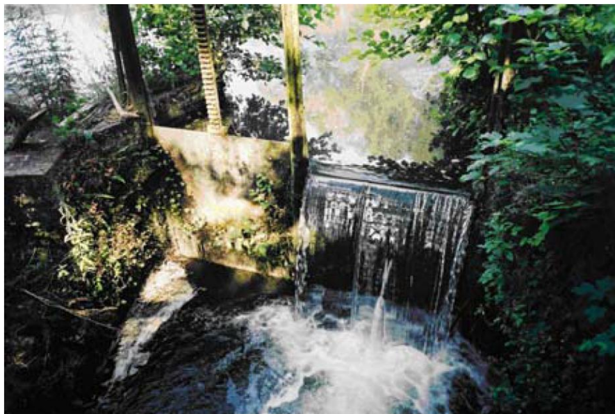
Ouvrage infranchissable vanne fermée
