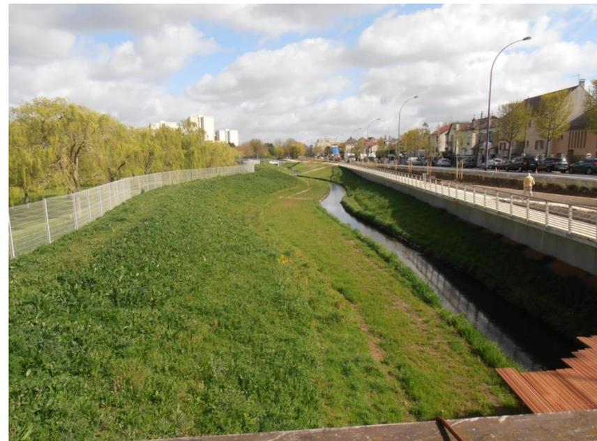
Construire une rivière à l'hydro-morphologie naturelle insérée dans le système d'assainissement d'eaux pluviales
