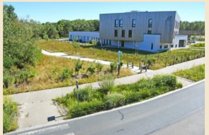
Aménagement d'une zone d'activités commerciales
