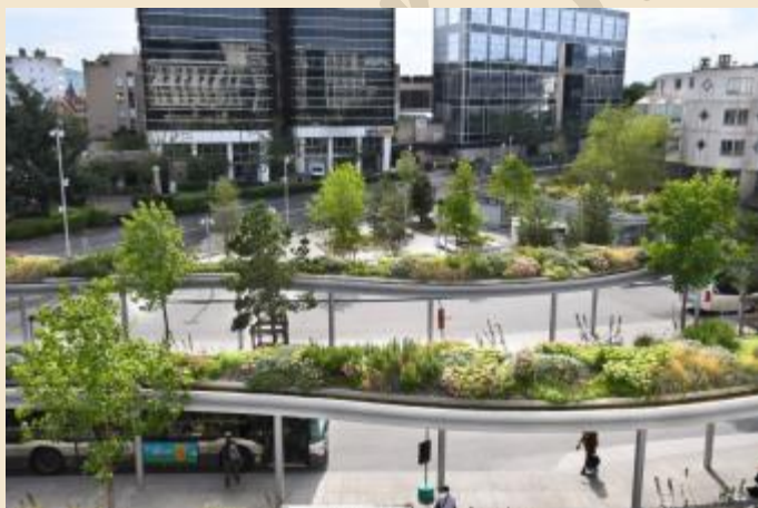
Aménagement d'une gare routière
