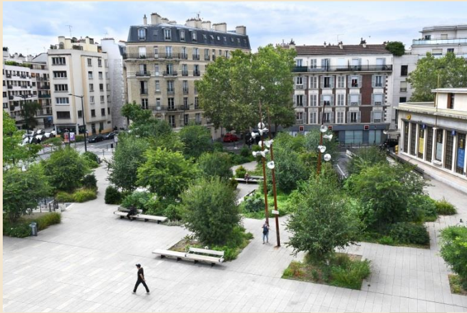
Aménagement d'un parvis
